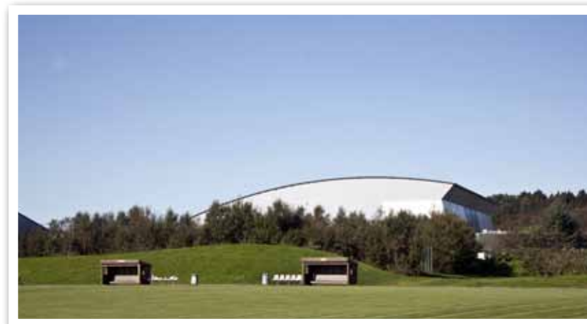
:: Randaberg Arena ruver i terrenget. Her sett fra Idrettsparken ved Randaberghallen.
