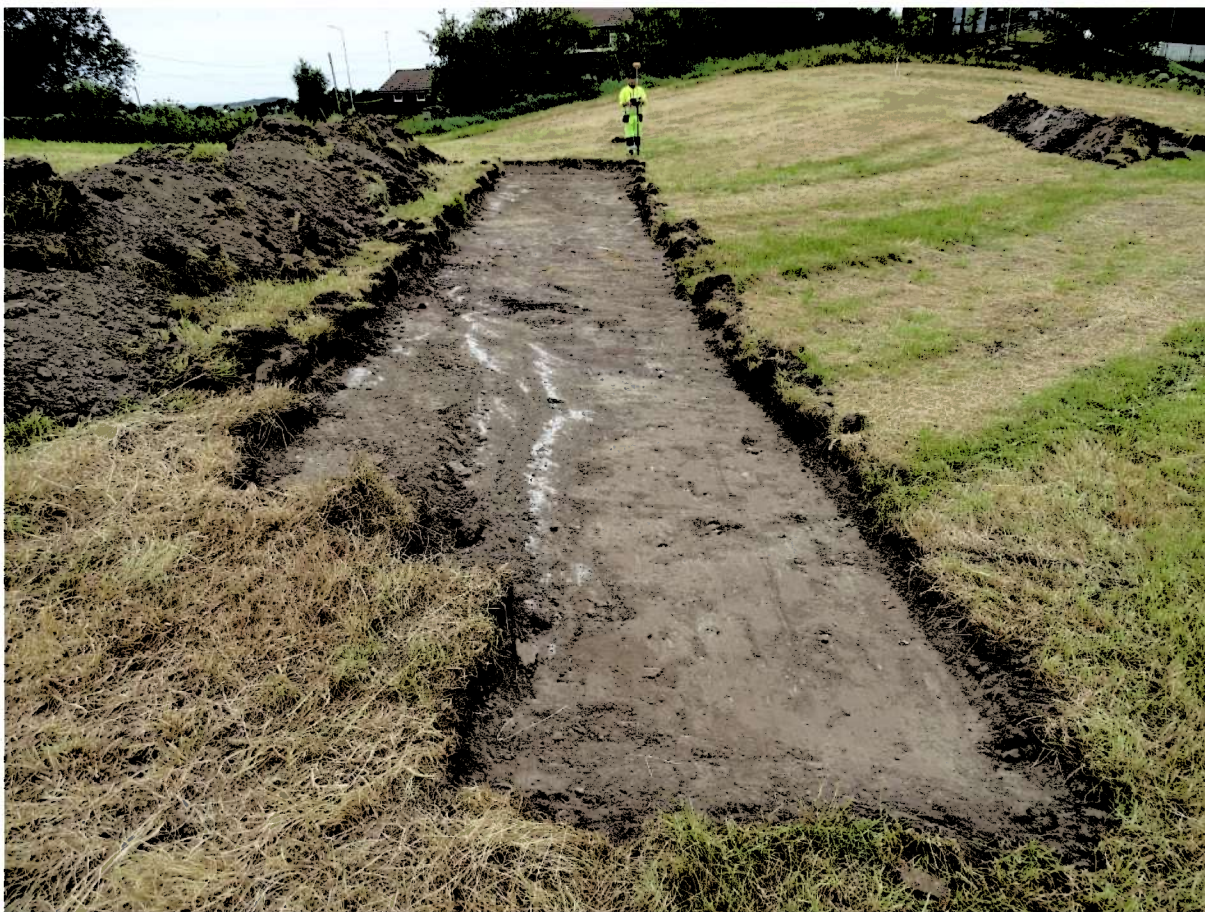
Figur 7: Sjakt 1.1 (foto nr. 4).
