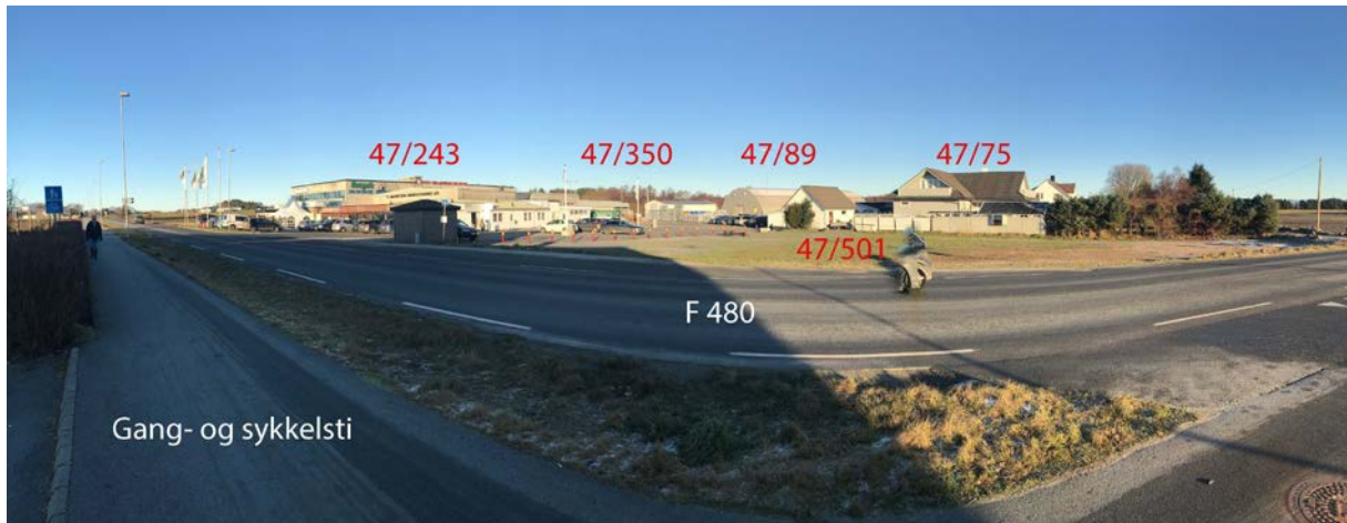
180 graders panorama av planområdet sett fra Randabergveien.
