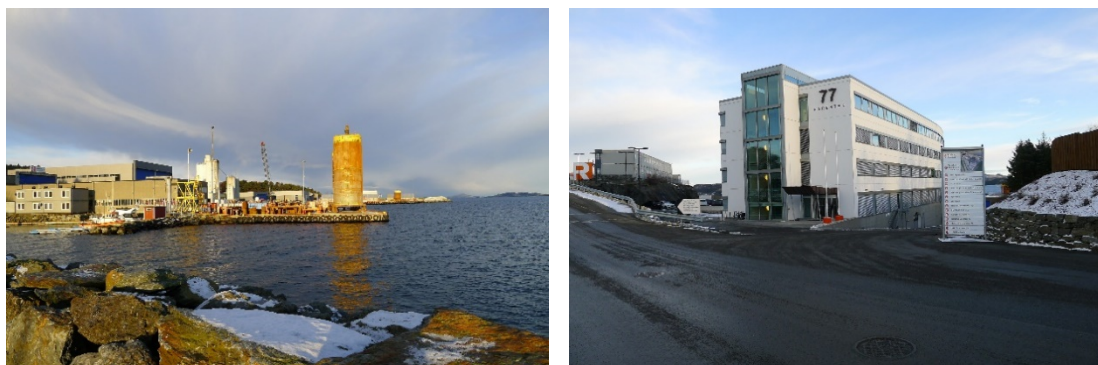
Figur 24 Delområdet er preget av industrivirksomhet og kontorbygg
