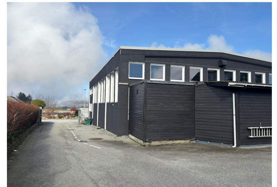
Eksisterende bebyggelse, sørvendt fasade, utsikt mot nord
